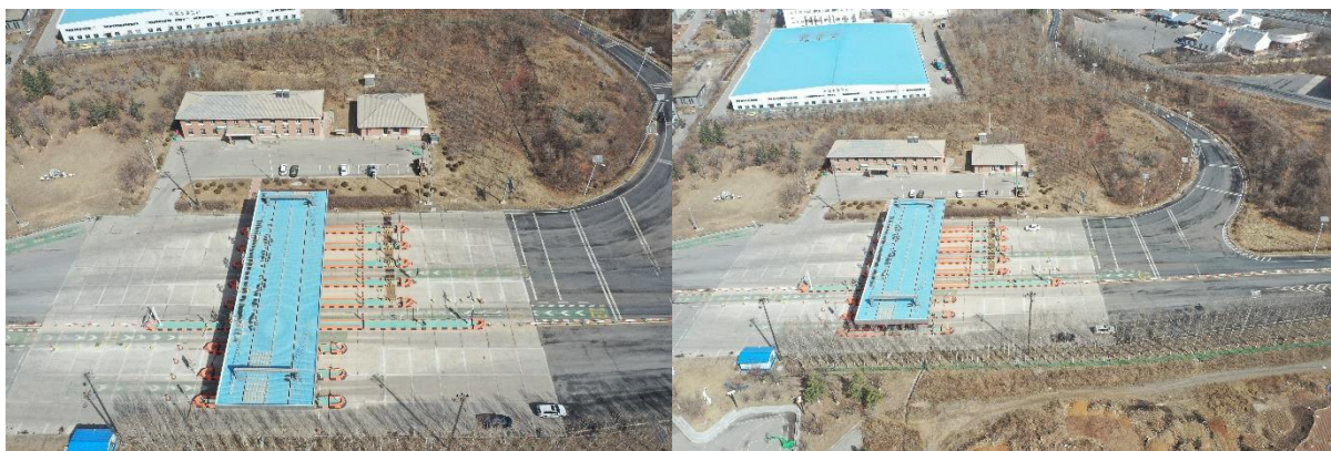
图 1.1-6 收费站改造工程区现状图
