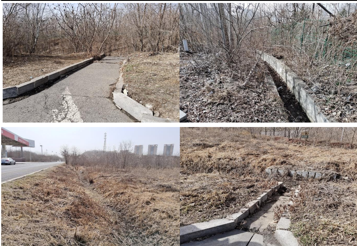
图 4.1-1 水土保持工程措施照片
