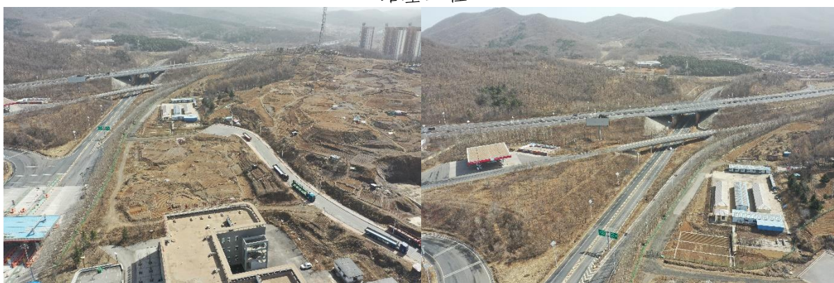
互通立交工程
