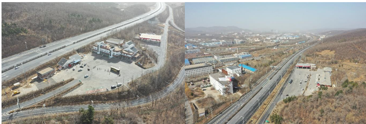
图 1.1-5 服务区改造工程区现状图
