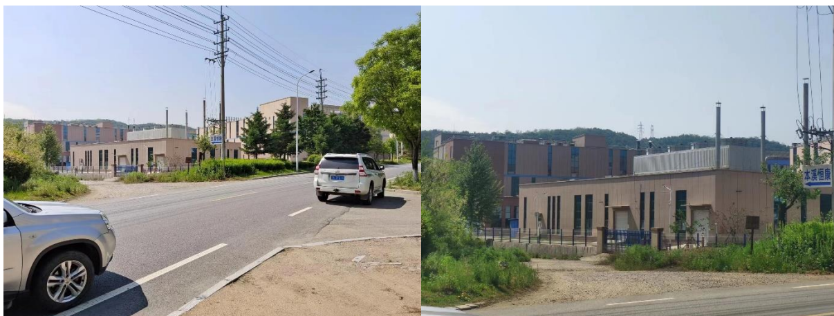
图 3.3-1 弃土场现状情况
