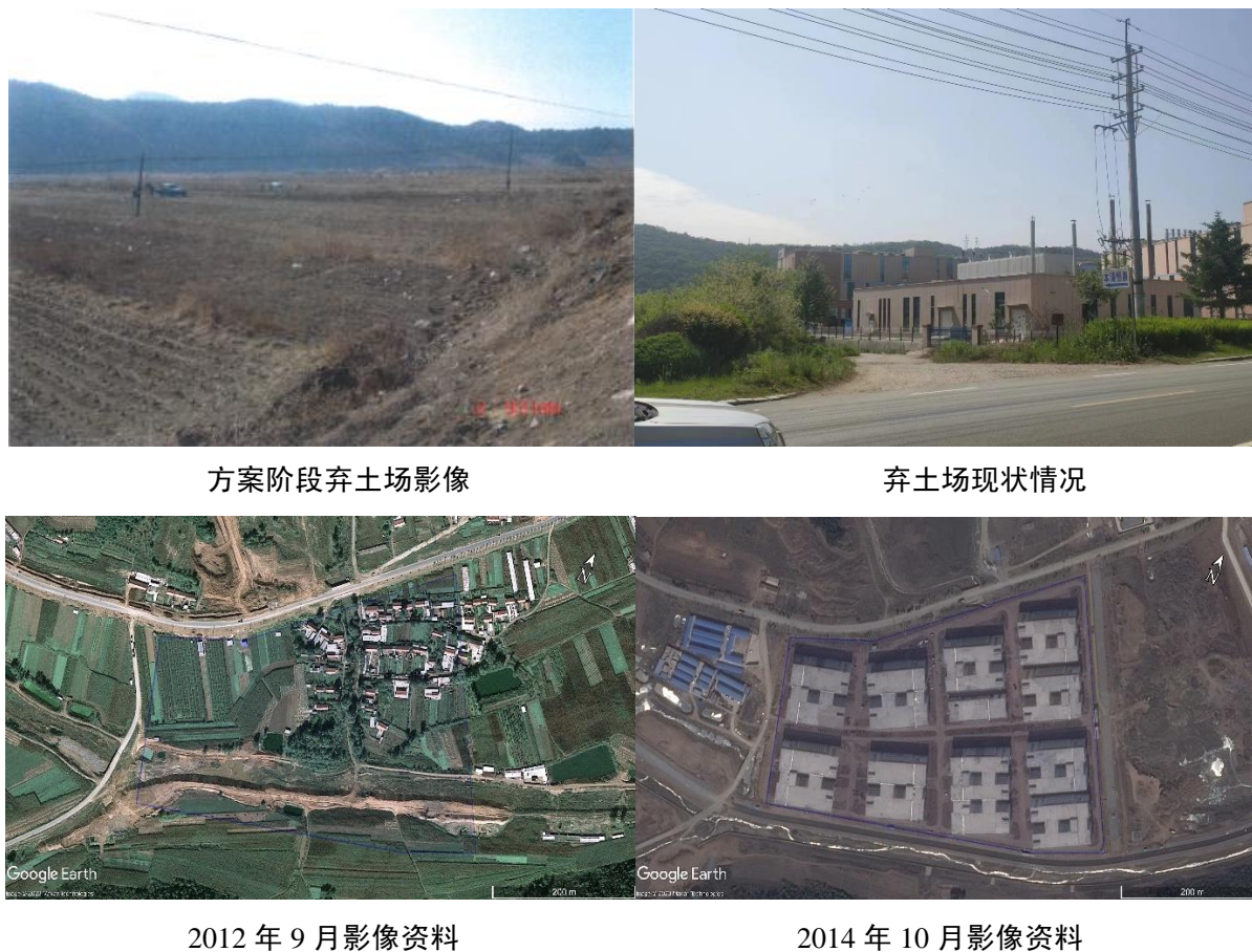
图 1.1-7 弃渣场工程区
